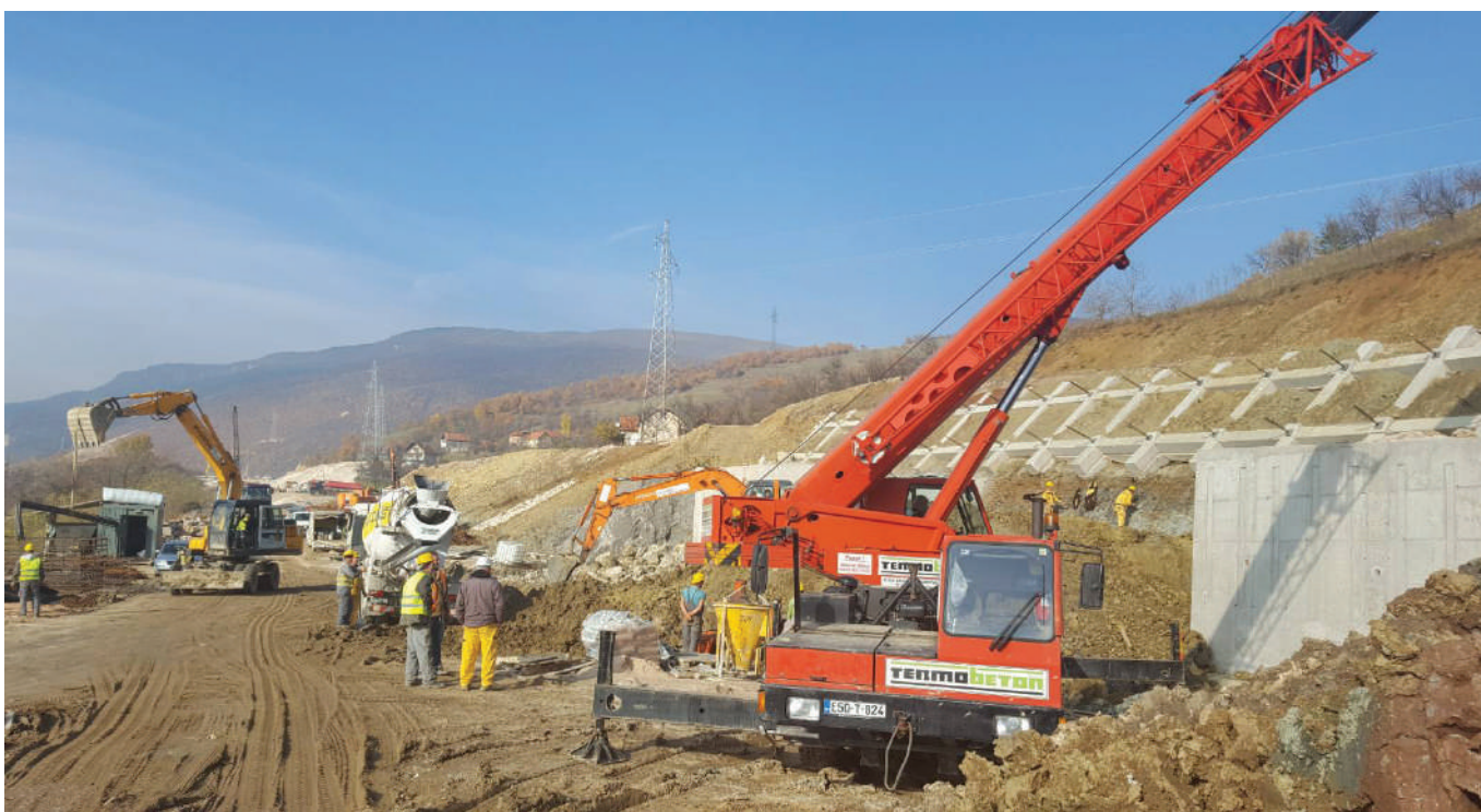
Izrada armirano-betonskog zida sa kontraforima i roštiljska konstrukcija u Zenici (Koridor Vc)
