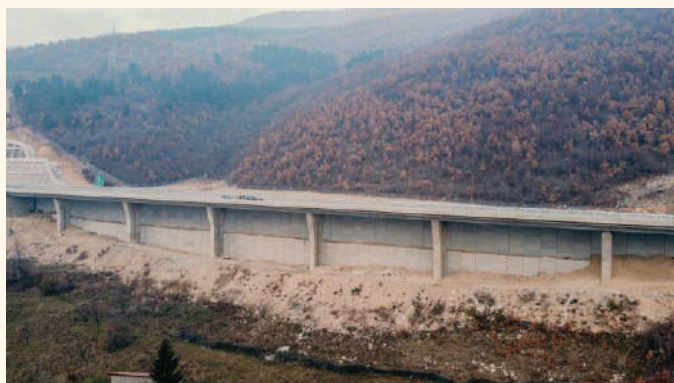
Zidovi od armiranog tla na dionici autoputa Počitelj-Bijača (lijevo), te na dionici autoputa Klopče-Donja Gračanica (desno)
