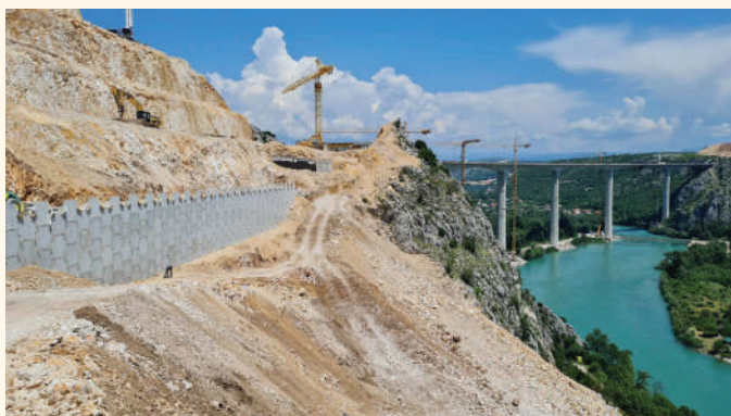
Zidovi od armiranog tla na dionici autoputa Počitelj-Bijača (lijevo), te na dionici autoputa Klopče-Donja Gračanica (desno)
